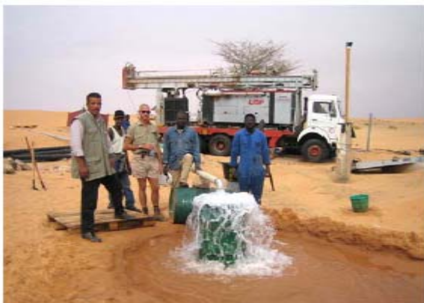
Essais de pompages dans la nappe d'eau saline
